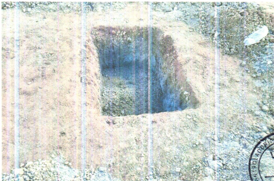
FOTO 16 – Regularização e compactação do fundo de vala
